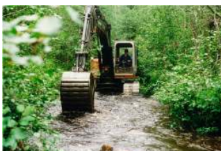
Kuva 1. Kunnostuksessa käytettiin sekä kone- että miesvoimaa.
