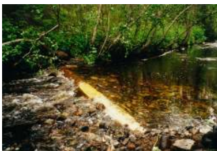
Kuva 3. Puukunnostuksessa kynnykset rakennettiin puutukeista.
